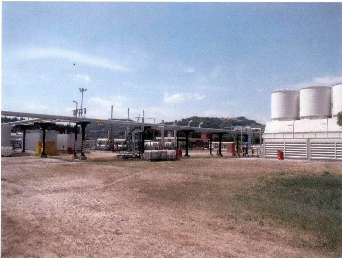
Centrale “San Giorgio Mare
