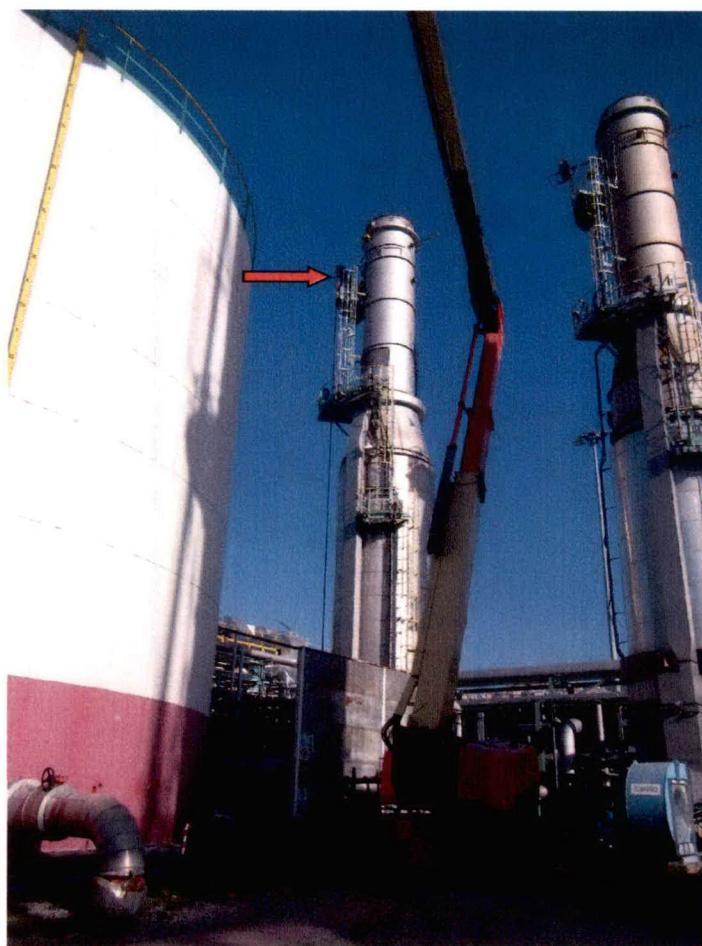
Foto 8: punto di emissione E04 (freccia rossa) in funzionamento come riserva del punto di emissione E04bis (visibile a destra)
