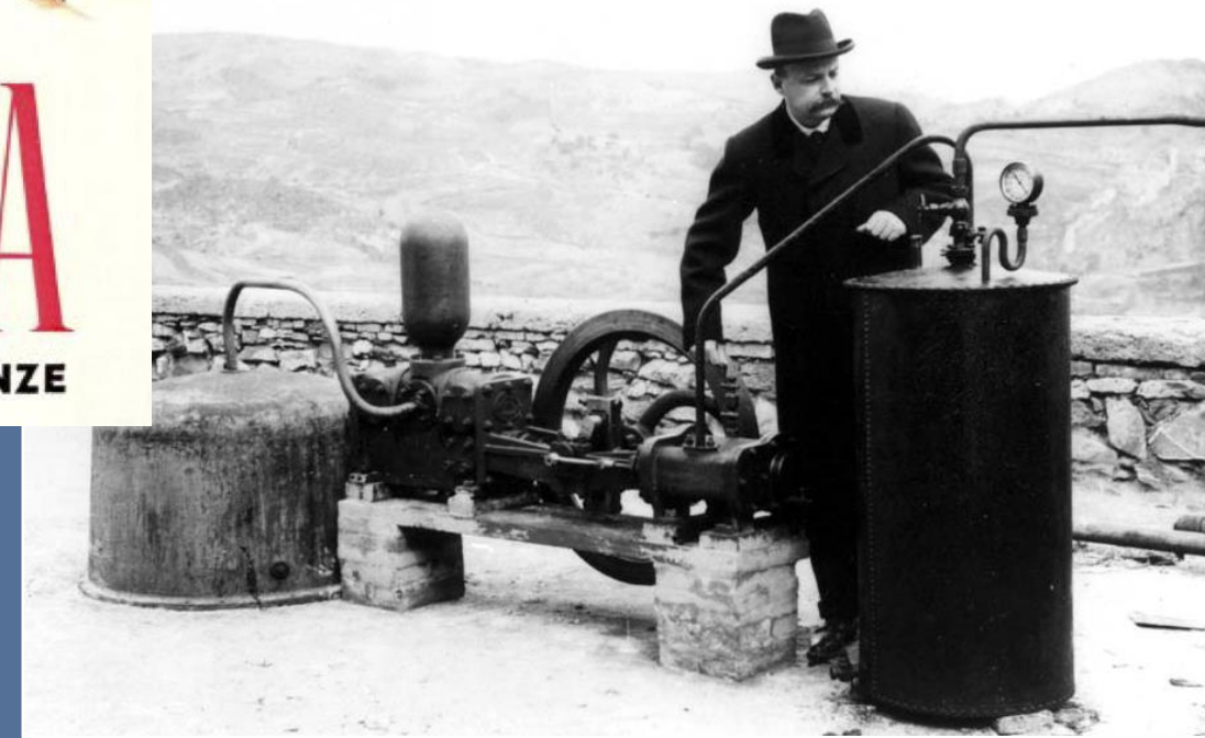
Larderello 1904 la prima energia elettrica geotermica
