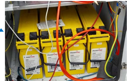
batterie tampone
