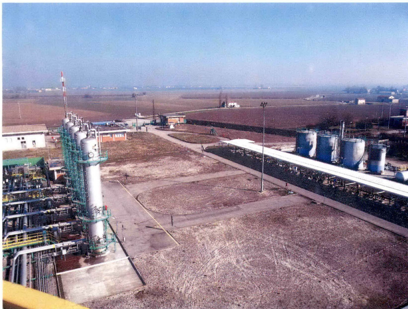
Centrale “Sabbioncello stoccaggio”
