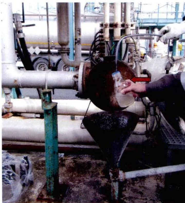
Foto 3 – Punto di campionamento reflui da baie di carico autobotte (freccia di colore rosso)
