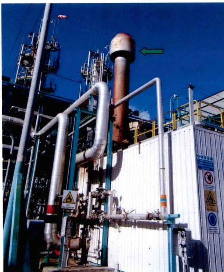
Foto 10: Punto di emissione E03 (camino indicato dalla freccia di colore verde)
