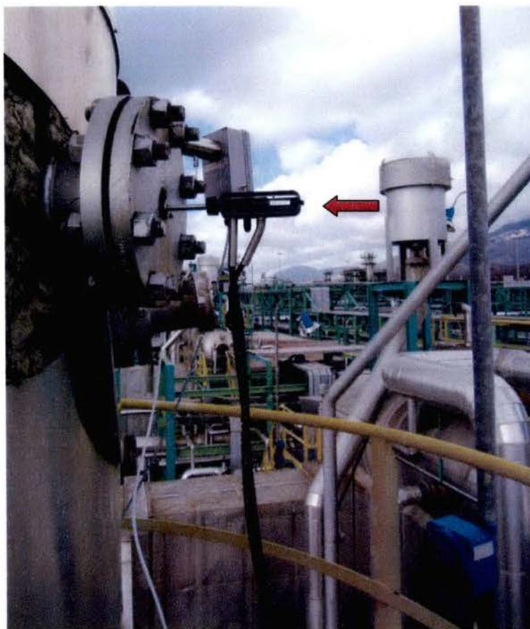
Foto 9: Punto di emissione E12c; foro di campionamento con sonda di prelievo (freccia di colore rosso)
