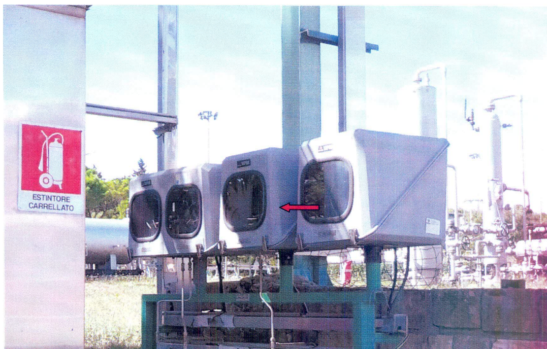
Foto 3 – Punto di campionamento “gas povero”, collettore da 8” (freccia di colore rosso)
