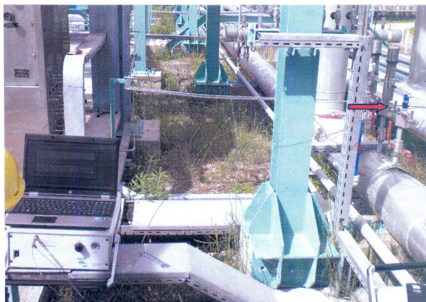
Foto 3 - Punto di campionamento (freccia di colore rosso) linea 360 “ gas associato ”
