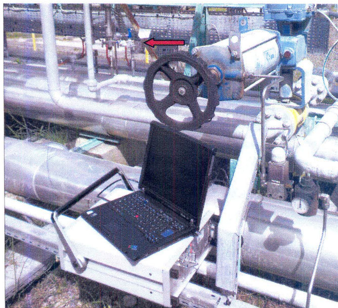
Foto 2 – Punto di campionamento (freccia di colore rosso) linea 300 “ gas povero ”
