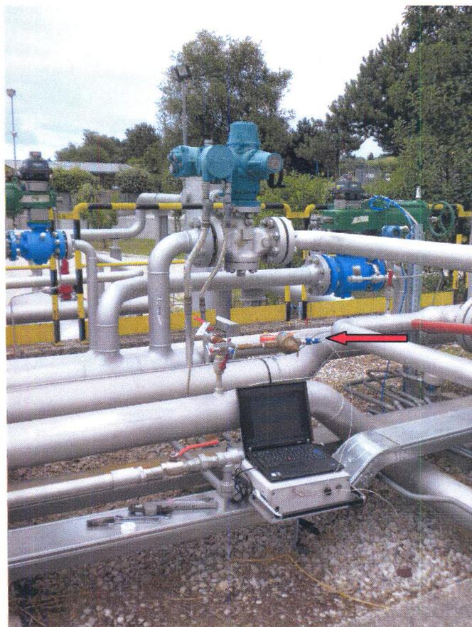
**Foto 5 – Punto di campionamento (freccia di colore rosso) e gascromatografo portatile µGC 3000 Agilent**
