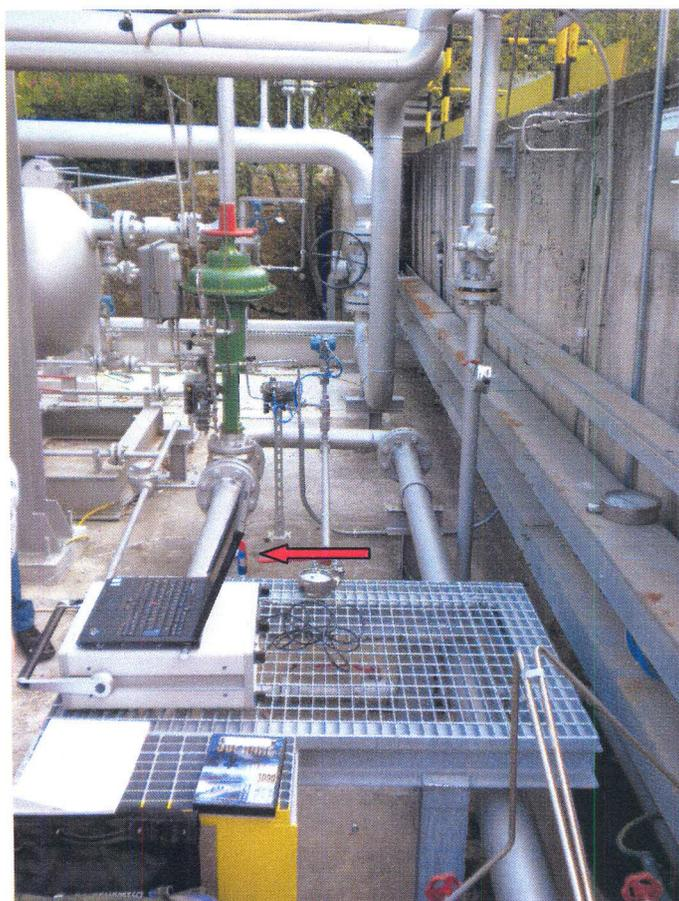
**Foto 3 – Punto di campionamento (freccia di colore rosso) e gascromatografo portatile  $\mu$ GC 3000 Agilent**
