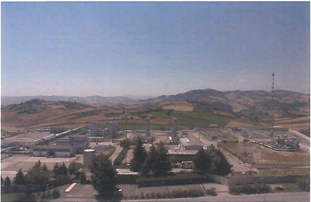
Centrale “Fiume Treste Stoccaggio”
