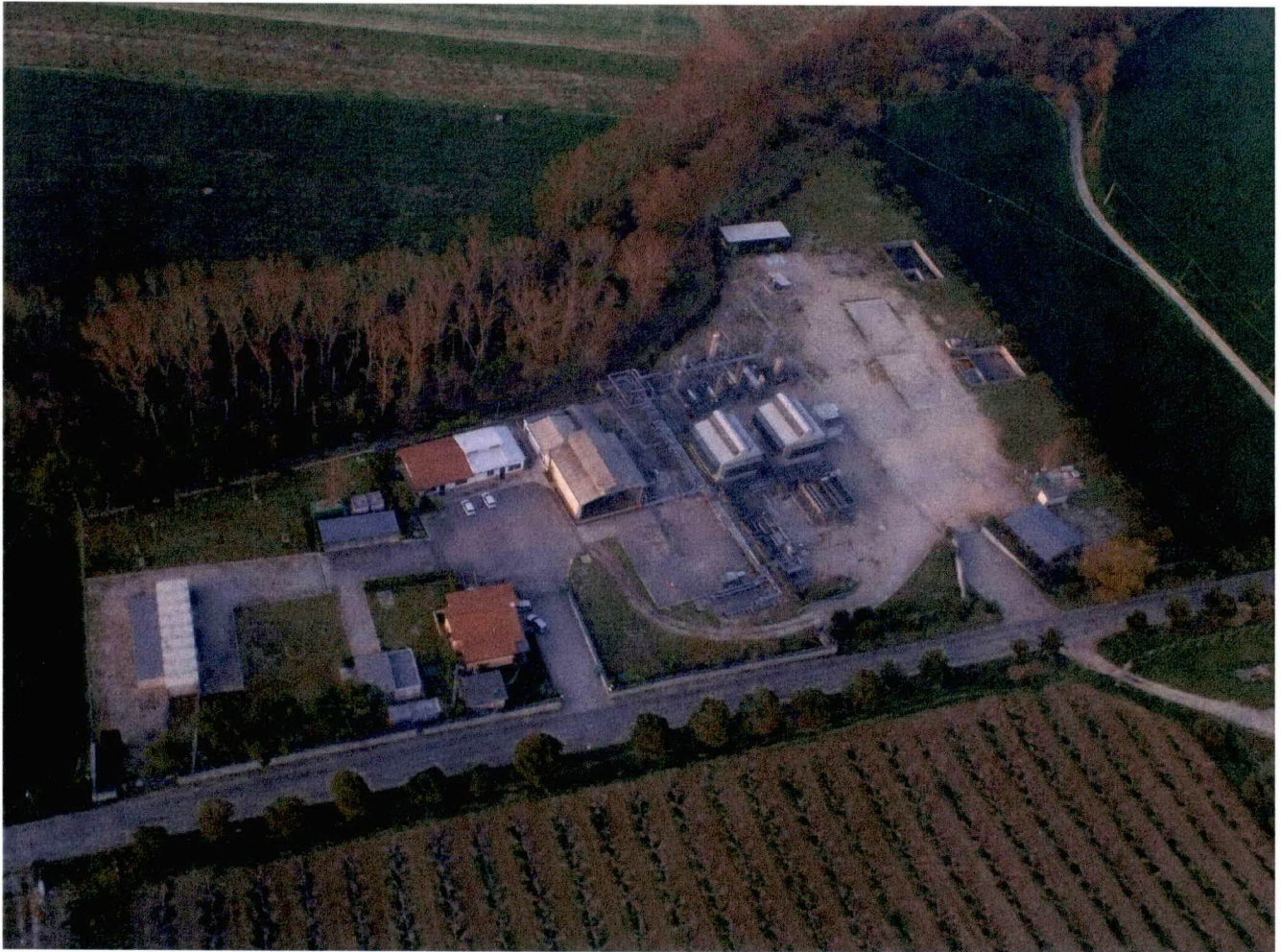
Centrale “Cellino stoccaggio”
