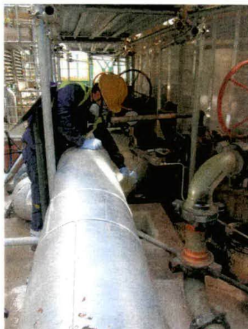
Foto 2 – Campionamento reflui da serbatoio di stoccaggio V560-TA-002
