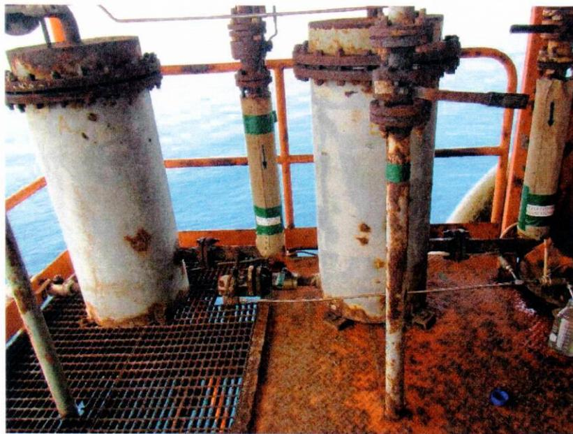
**Foto 5 - Impianto di trattamento con filtri a carbone attivo**
