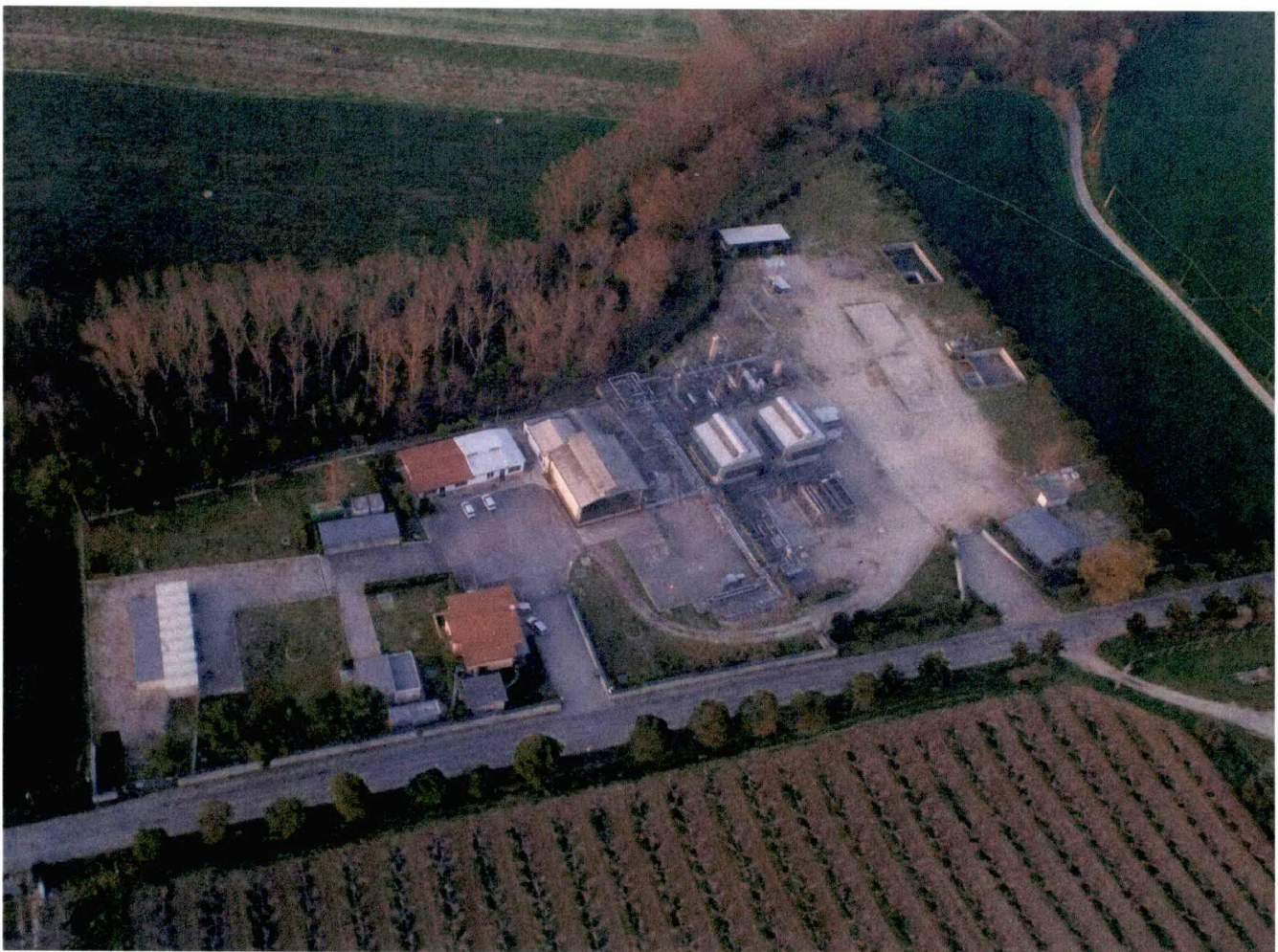
Centrale “Cellino stoccaggio”
