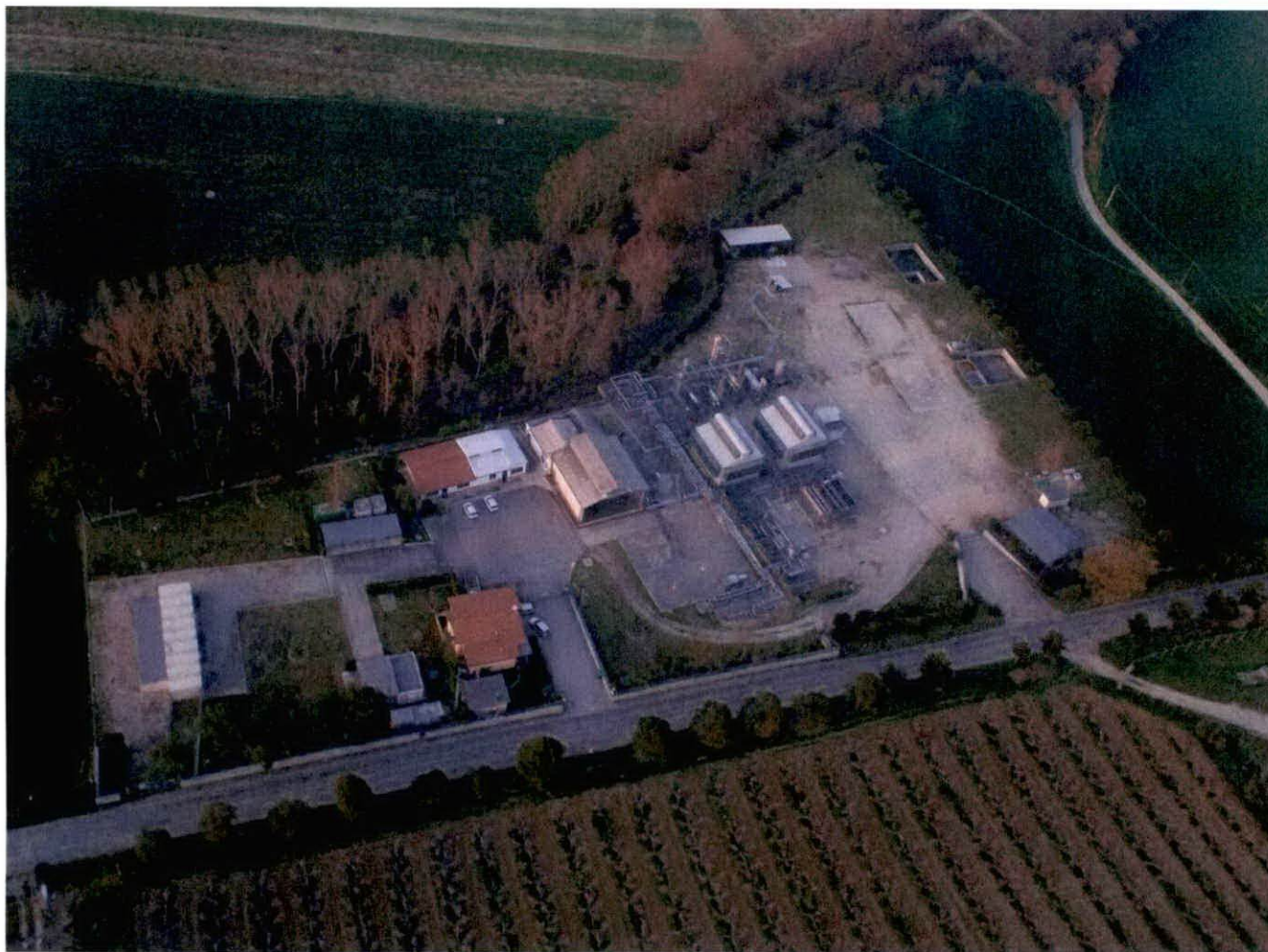
Centrale “Cellino stoccaggio”
