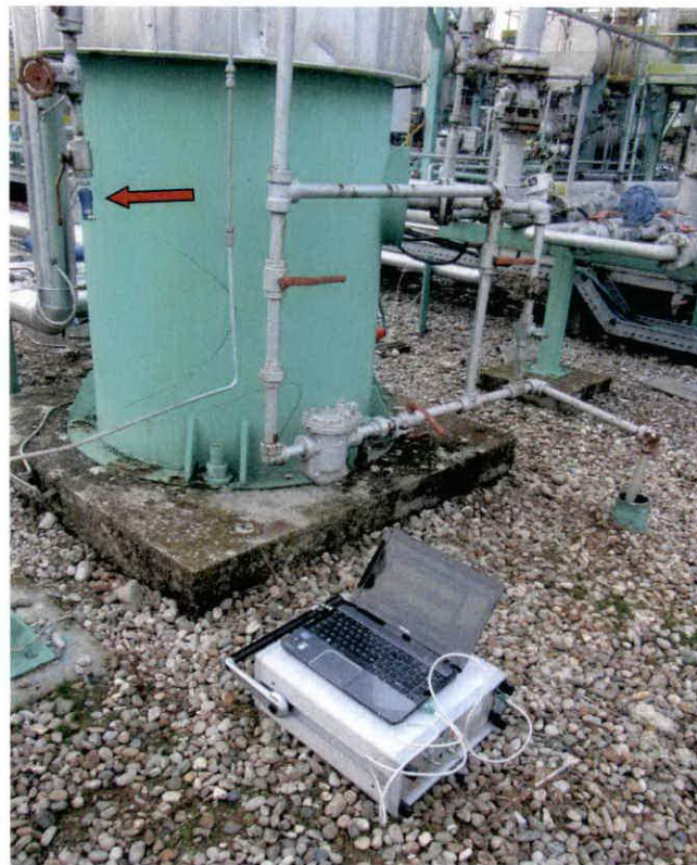
Foto 1 – Punto di campionamento (freccia di colore rosso)
