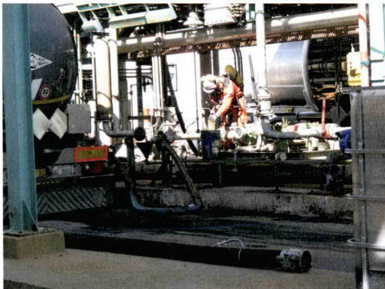
Foto 3 – Campionamento reflui da baie di carico autobotti
