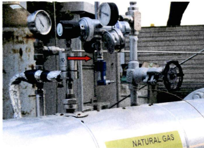
Foto 3 – Punto di campionamento “miscela gas” (freccia di colore rosso)
