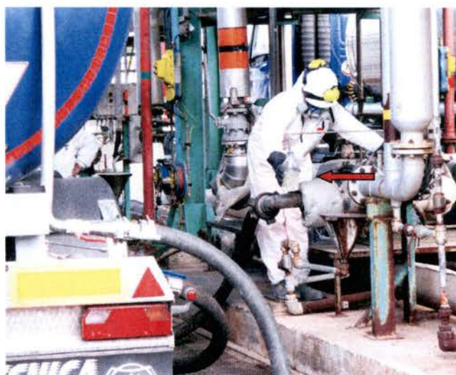
Foto 3 – Punto di campionamento reflui da baie di carico autobotte (freccia di colore rosso)
