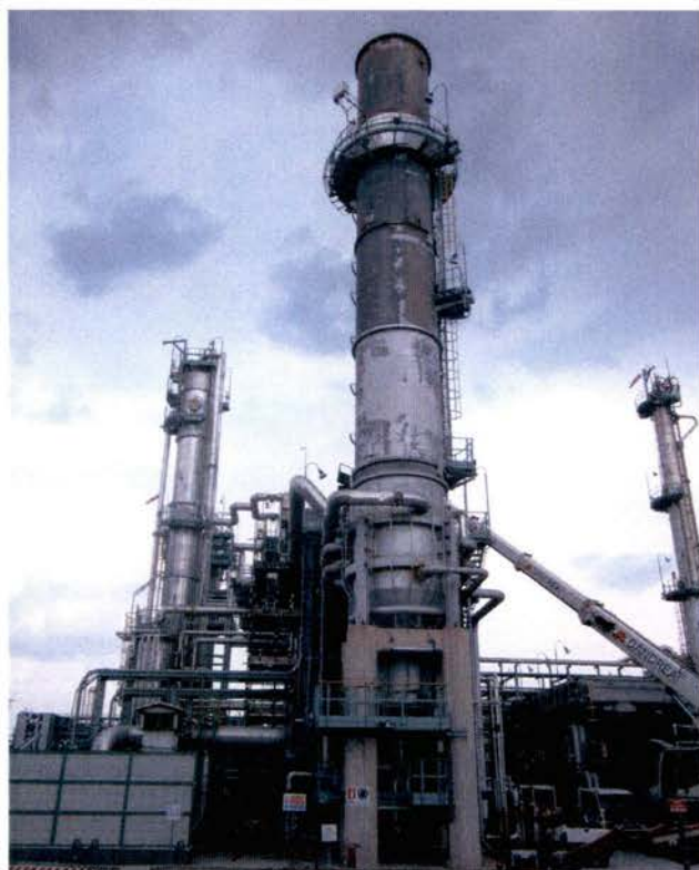
Foto 19: Punto di emissione E20
