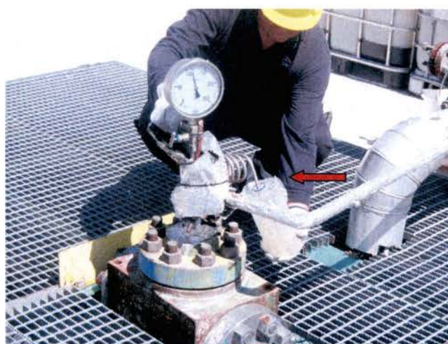
Foto 4 – Punto di campionamento reflui dall'area pozzo Costa Molina 2 (freccia di colore rosso)
