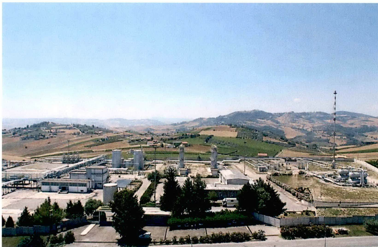
Centrale “Fiume Treste stoccaggio”
