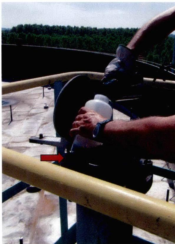
Foto 3 – Punto di campionamento idrocarburi liquidi da serbatoio stoccaggio 13-TK1 (freccia di colore rosso)
