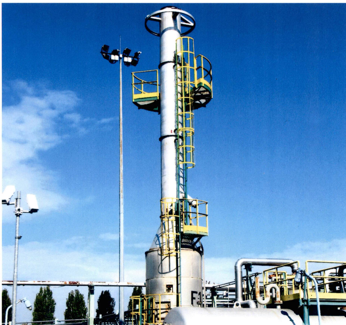
Centrale “Rubicone”: Termodistruttore F-1
