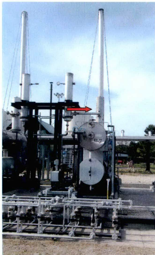
Foto 6: Punto di prelievo dei fumi (freccia rossa)
