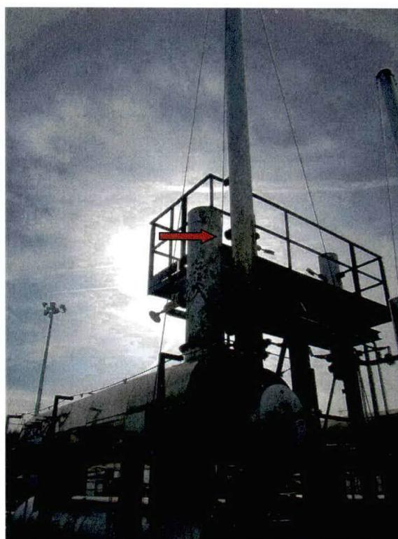
Foto 7: Punto di campionamento con sonda di prelievo
