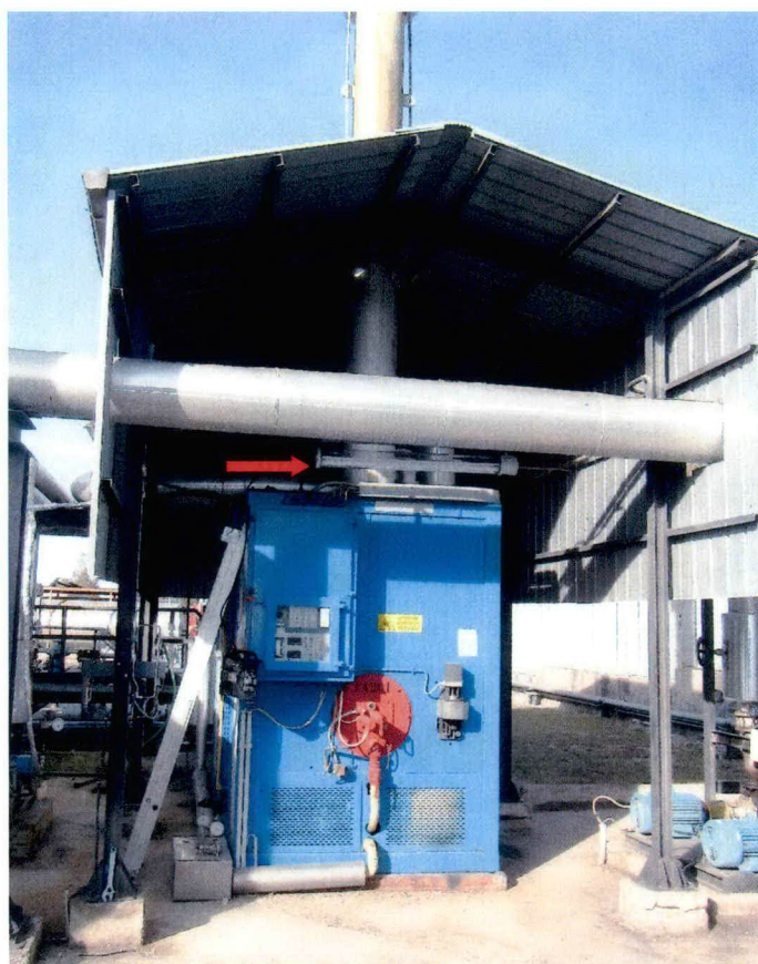
Foto 2: Punto di campionamento con sonda di prelievo (freccia rossa)
