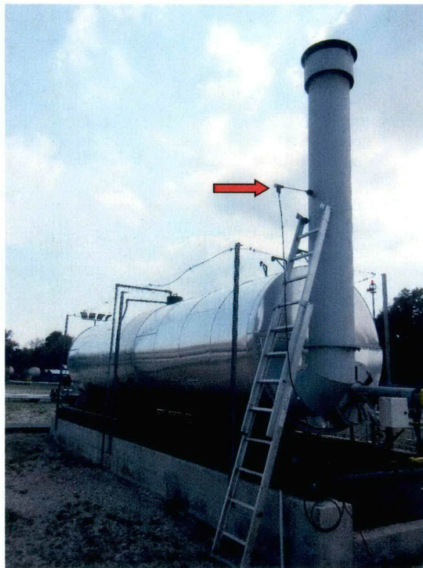
Foto 3: Punto di campionamento con sonda di prelievo (freccia rossa)
