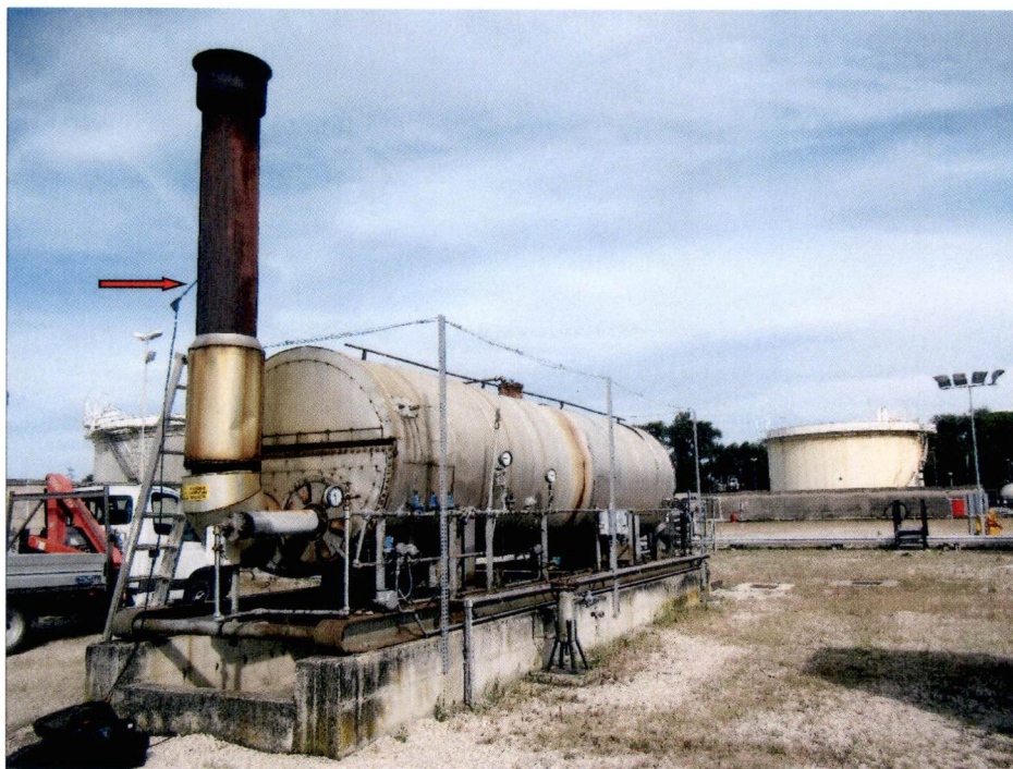
Fig. 2 - Punto di prelievo dei fumi (freccia rossa)
