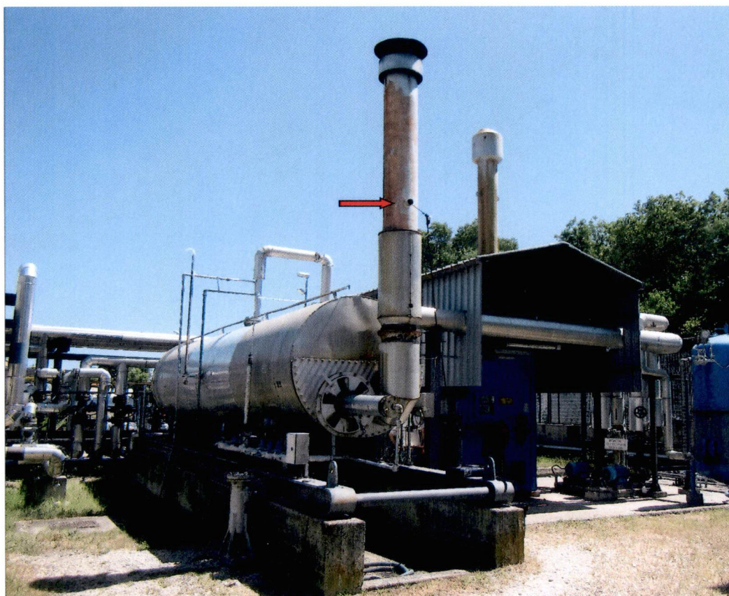
Fig. 4 - Punto di prelievo dei fumi (freccia rossa)
