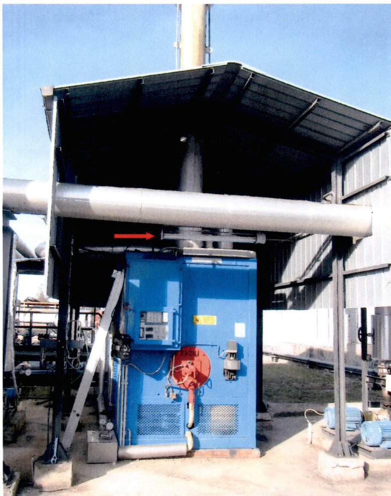
Fig. 3 - Punto di prelievo dei fumi (freccia rossa)
