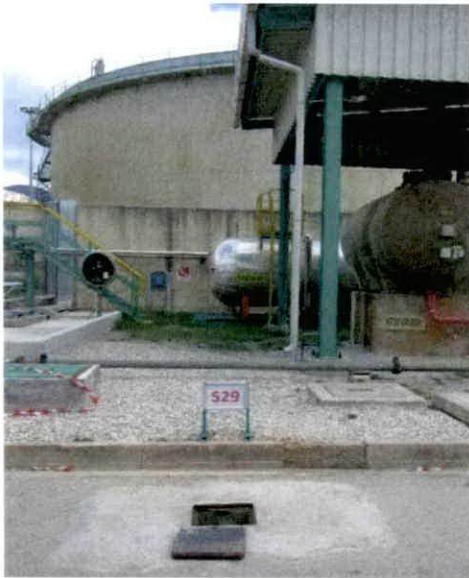
Pozzetto piezometrico S29 in adiacenza serbatoio D
