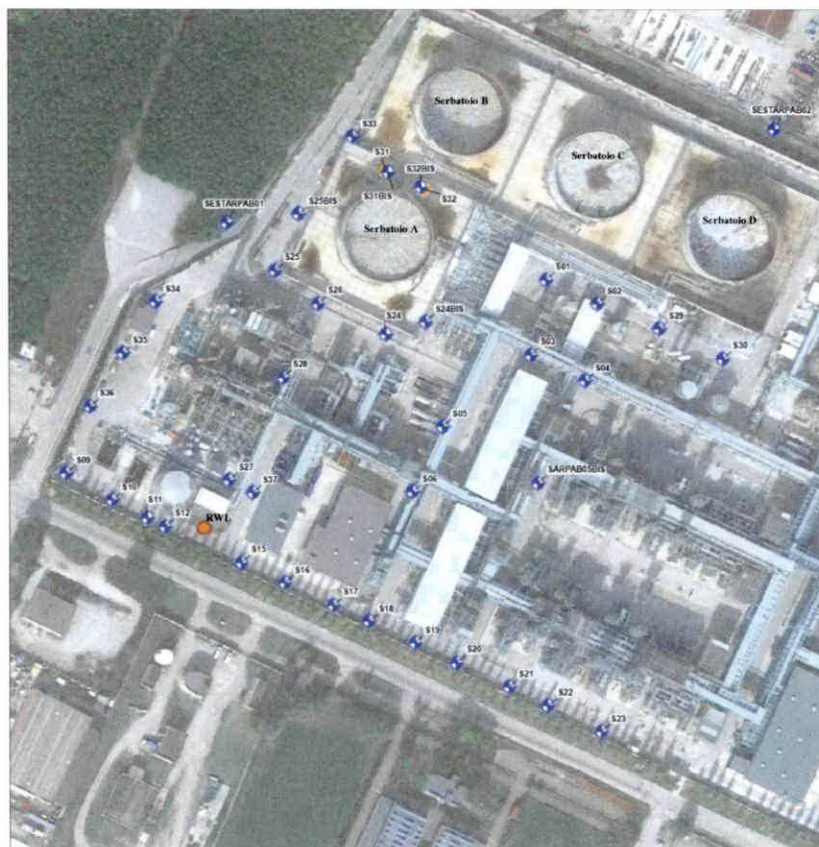
Figura 1- Centro olio con indicazione dei pozzi piezometrici e dei serbatoi stoccaggio olio
