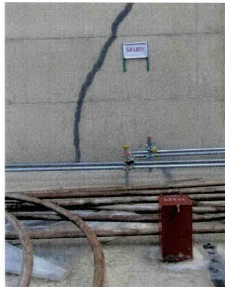
Pozzetto piezometrico S31bis all'interno area serbatoio A
