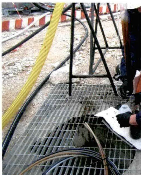
Campionamento dal pozzo RWL nell'area di scavo
