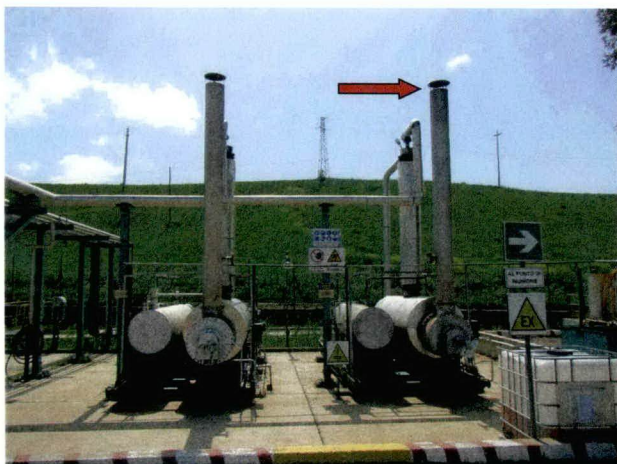
Foto 2: Punto di emissione E001
