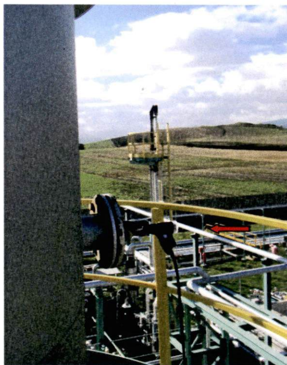
Punto di campionamento con sonda di prelievo
