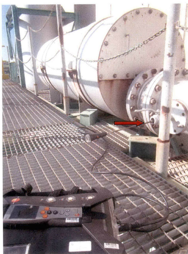
Foto 3: punto di prelievo con sonda (freccia rossa)
