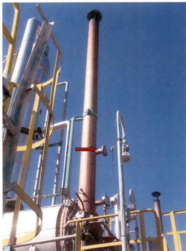
Foto 6: punto di prelievo con sonda (freccia rossa)
