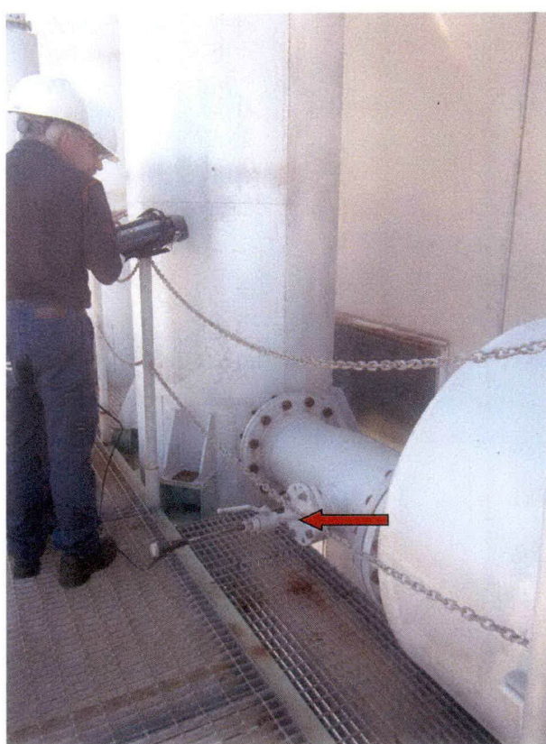
Foto 7: punto di prelievo con sonda (freccia rossa)
