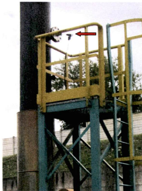
Punto di campionamento con sonda di prelievo
