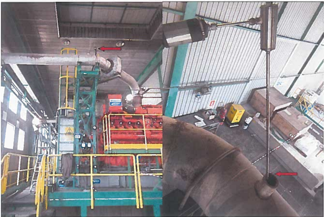
Foto 1 e 2: Motocompressore gas 360-MG-301 e punto di prelievo dei fumi (frece rosse)
