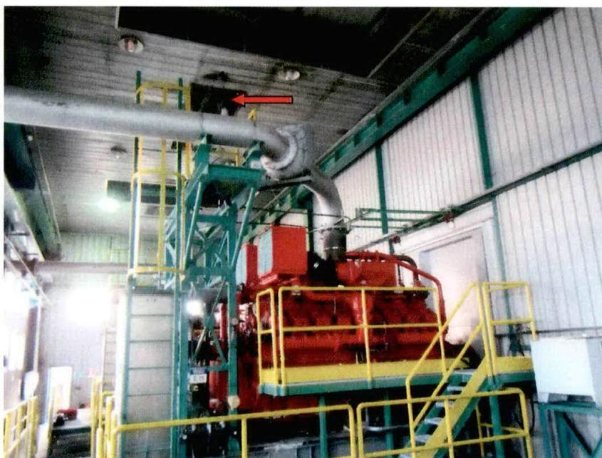
Motocompressore gas 360-MG-201 e punto di prelievo dei fumi (freccia rossa)
