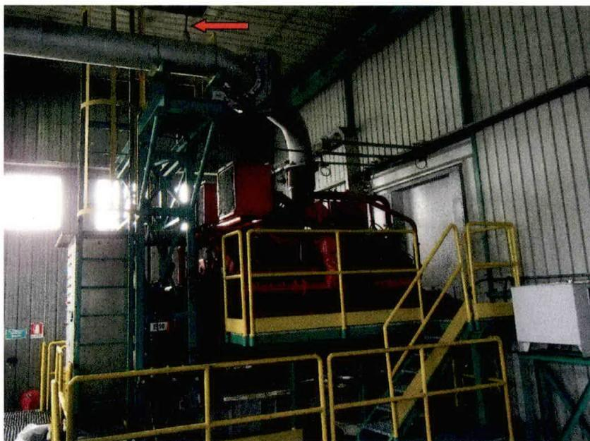
Motocompressore gas 360-MG-101 e punto di prelievo dei fumi (freccia rossa)
