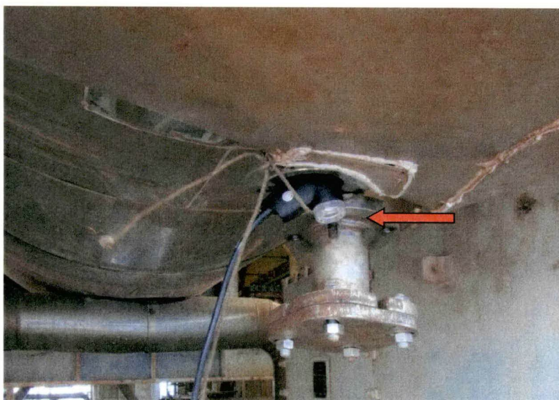
Foto 4: punto di campionamento con sonda di prelievo
