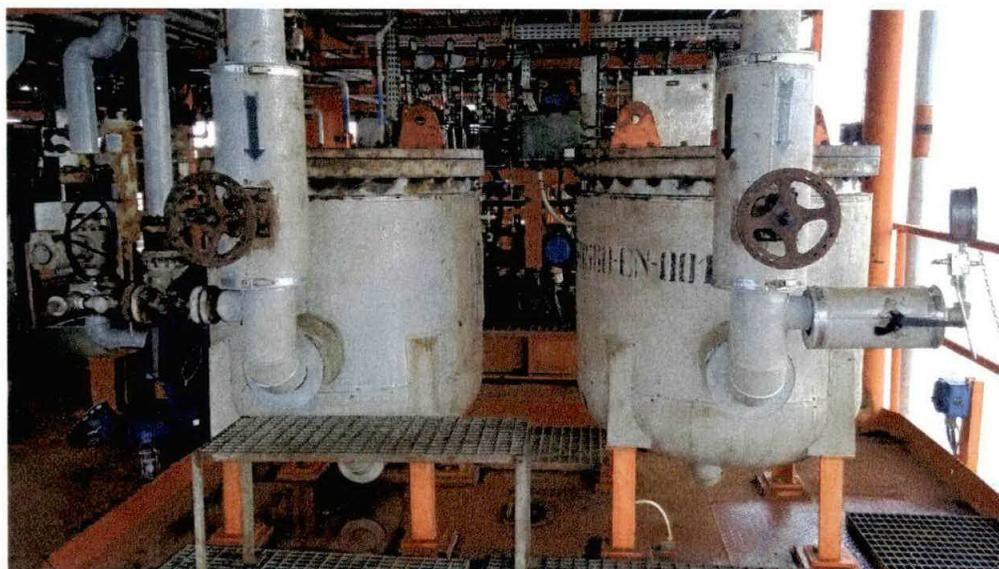
Foto 4 - Impianto di trattamento con filtri a carbone attivo
