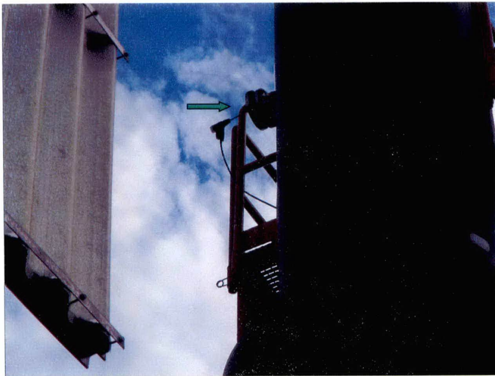
Foto 2: punto di prelievo nel camino E01 (freccia di colore verde)
