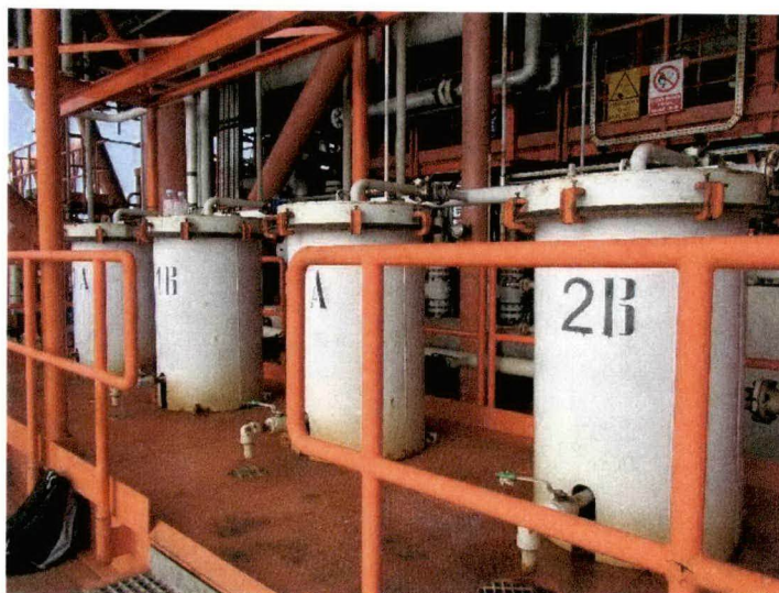
Foto 4 - Impianto di trattamento con filtri a carbone attivo
