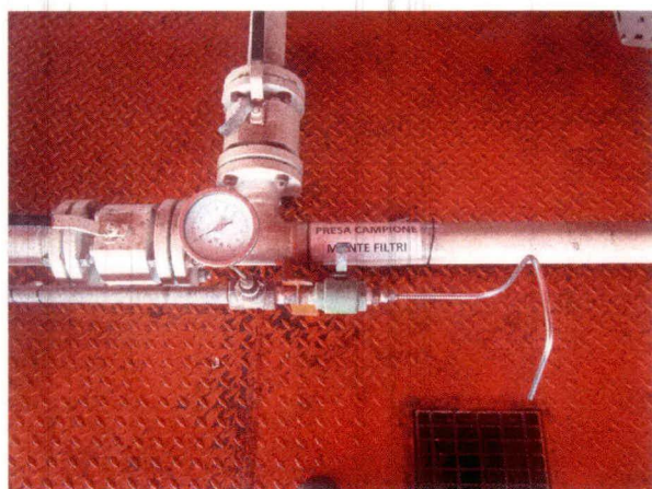
Foto 2 – Punto per campionamento a monte filtri
