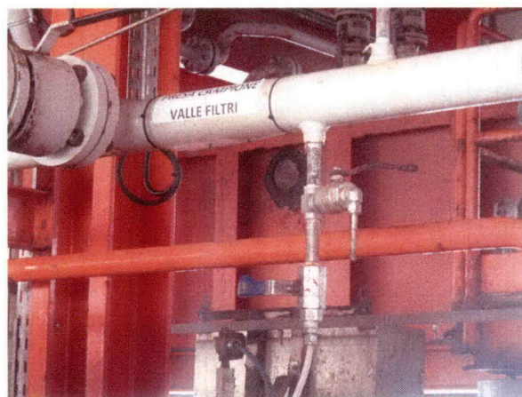
Foto 3 – Punto per campionamento a valle filtri
