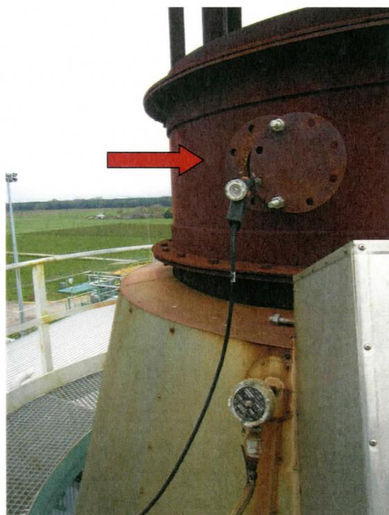
Punto di campionamento con sonda di prelievo
