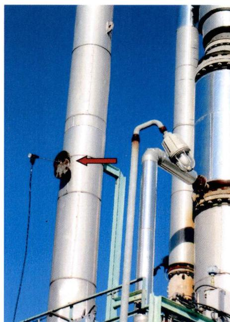
Punto di campionamento con sonda di prelievo
