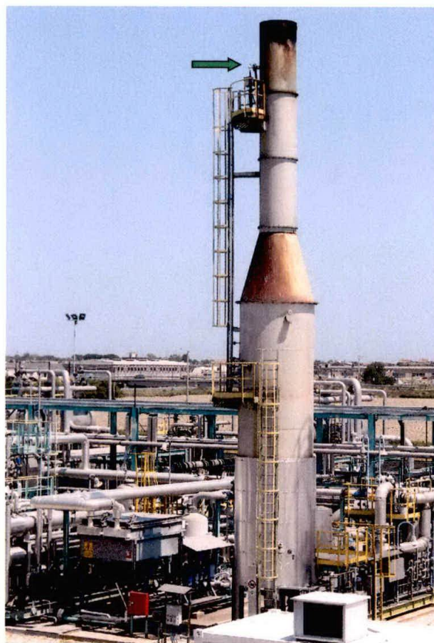
Punto di emissione E1 (punto di campionamento indicato dalla freccia di colore verde)
