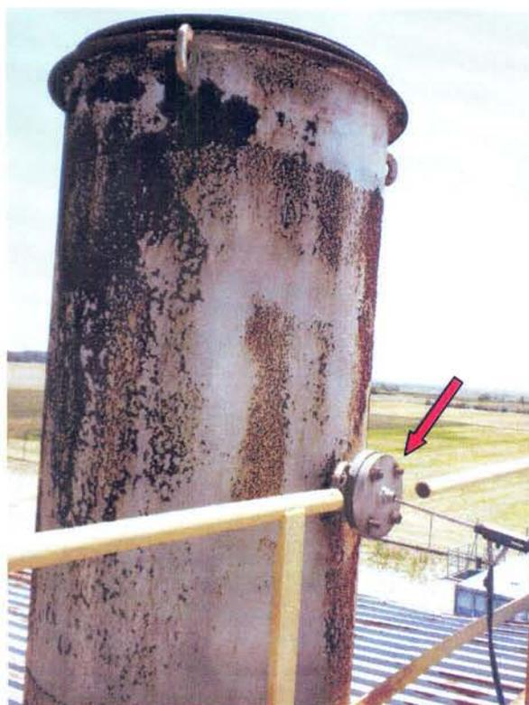
**Foto 2: Punto di emissione E15/a; foro di campionamento con sonda di prelievo (freccia di colore rosso)**
