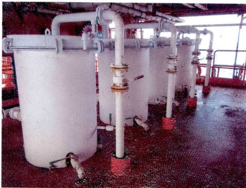
Foto 5 - Impianto di trattamento con filtri a carbone attivo
