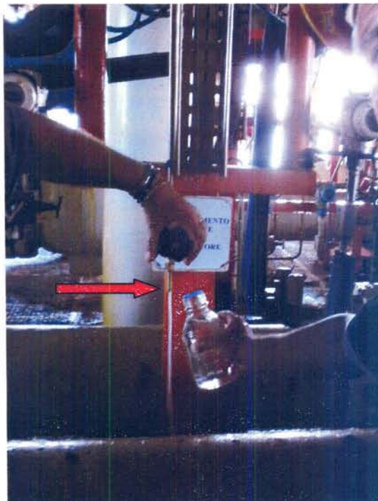
Foto 2 – Punto di campionamento SF1 - prelievo acque di raffreddamento (freccia di colore rosso)
