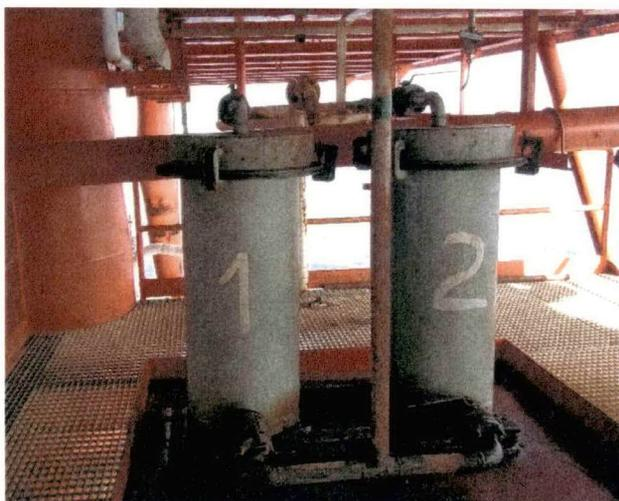
Foto 4 - Impianto di trattamento con filtri a carbone attivo
