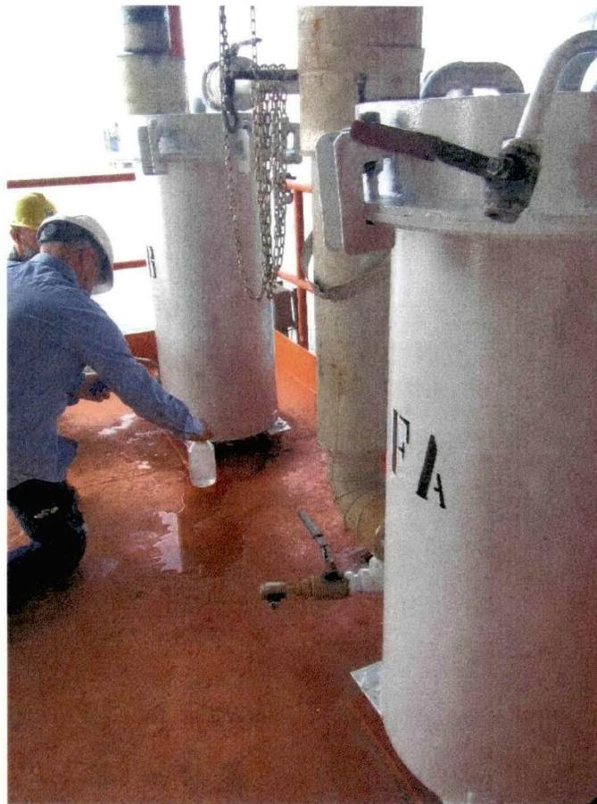
Foto 2 - Impianto di trattamento con filtri a carbone attivo
