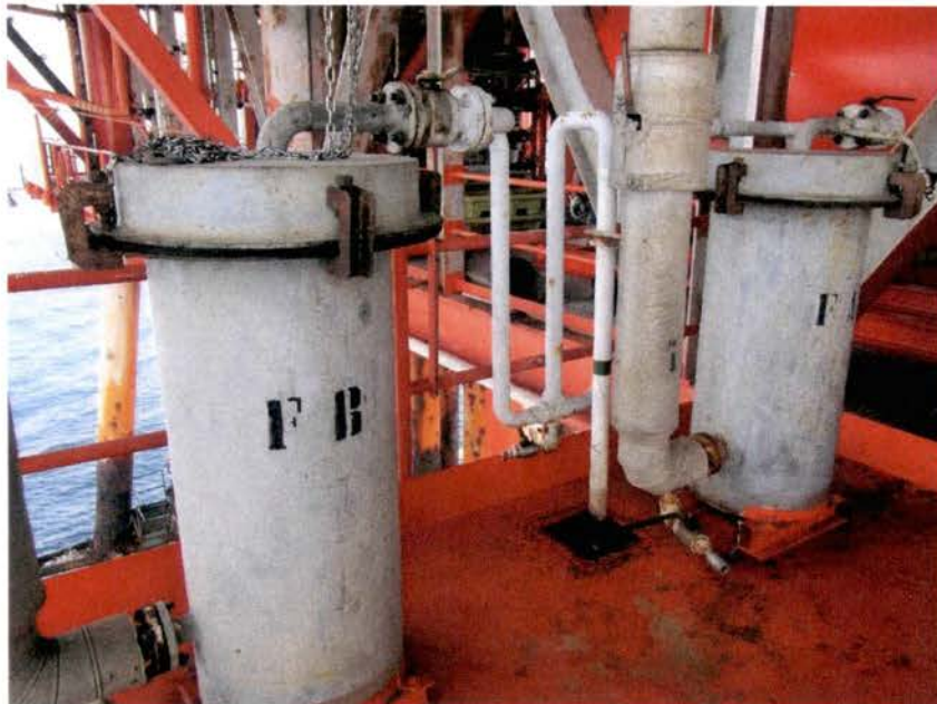
Foto 4 - Filtri a carbone attivo
