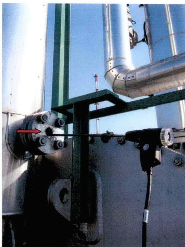
Fig. 6: Punto di prelievo dei fumi (freccia rossa)
