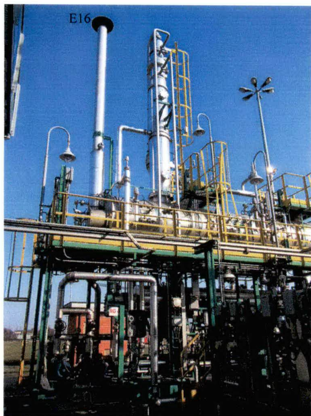
Fig. 5: Punto di emissione E16 rigeneratore glicol trietilenico
