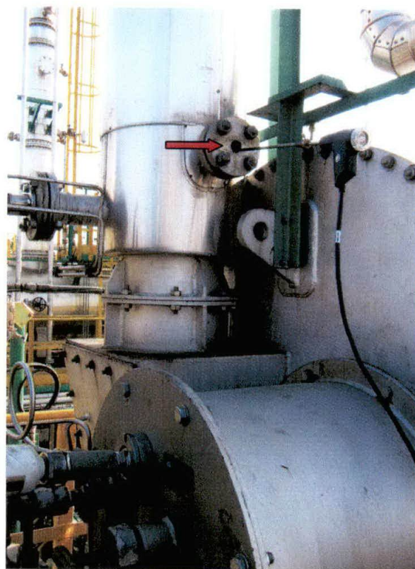
Fig. 3: Punto di prelievo dei fumi (freccia rossa)
