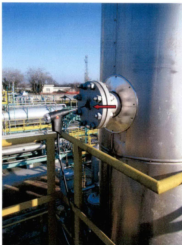
Fig. 3: Punto di prelievo dei fumi (freccia rossa)
