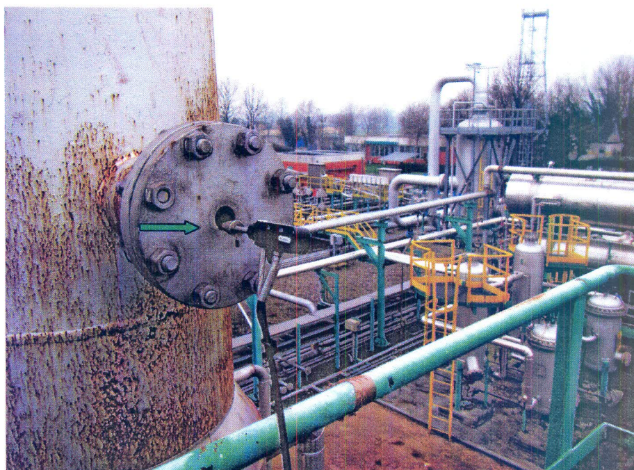
Foto 2: Punto di prelievo nel camino "E13" (freccia verde)
